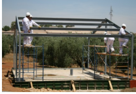
Montaje de estructura
