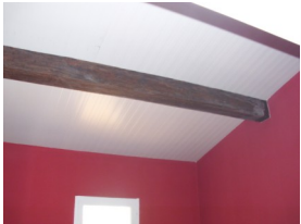
Detalle Acabado techo
